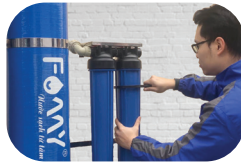
8. Lắp cốc lọc 20 inch kèm lõi PP 5 micron
