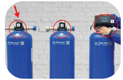
6. Kết nối các van vào các cột lọc theo số tương ứng
