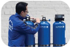
7. Cố định cột lên giá inox và kết nối đường ống nước
